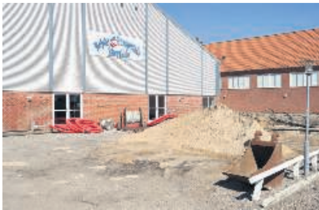
Byggerodet breder sig rundt om efterskolen i Rejsby. I uge 42 står en ny tilbygning med 2 klasseværelser og 6 elevværelser helt færdigt.
